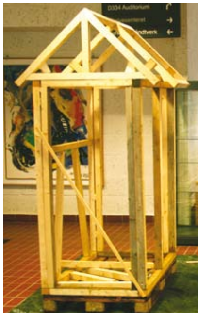
Studentene har bygd bindingsverk med en europall som fundament.
