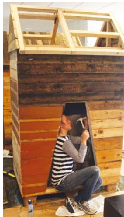
Åpninger kunne være mindre enn 9 cm og større enn 23 cm til dør/vindu og lignende.
