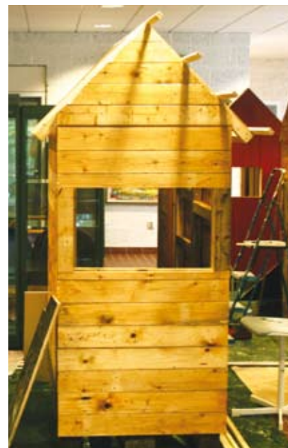
De har bygd takstoler og kledd konstruksjonen.
